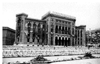
Zniszczony budynek biblioteki, Sarajewo Fot. Jan Piekło
