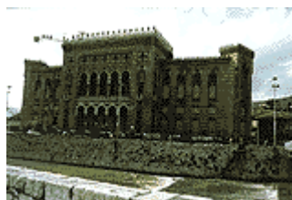
Sarajewo - odbudowywany budynek biblioteki Fot. Jan Piekło
